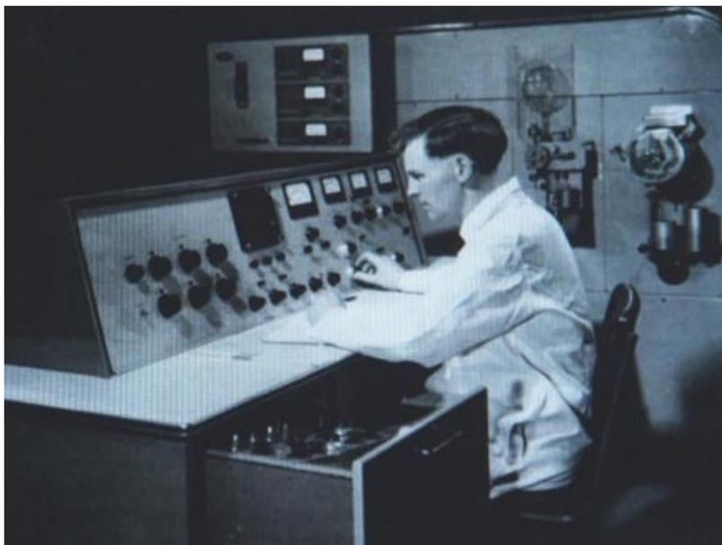
**Fig. 3** L'MS9 della ditta A.E.I., costruito nel 1962, una delle macchine ad alte prestazioni sulle quali hanno lavorato i pionieri della spettrometria di massa organica.
