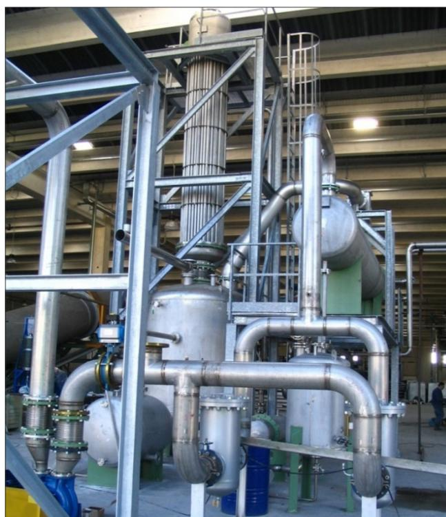
Fig. 5 - Impianto di condensazione del pyrogas
