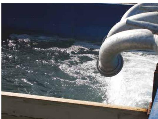
AIR LIQUIDE HA INSTALLATO OTTO IMPIANTI DI NEUTRALIZZAZIONE DELLE ACQUE REFLUE CON CO<sub>2</sub> NEI CANTIERI DELLA COSTRUENDA METROPOLITANA M5 DI MILANO, NELL'AMBITO DELLE INFRASTRUTTURE PER EXPO 2015. L'USO DI CO<sub>2</sub> OFFRE GARANZIE IN TERMINI DI SICUREZZA, RISPETTO DELL'AMBIENTE, EFFICACIA E SEMPLICITÀ D'IMPIEGO
