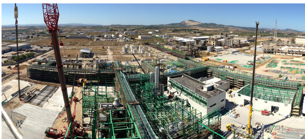
Una fase della costruzione dell'impianto Matrice di Porto Torres
