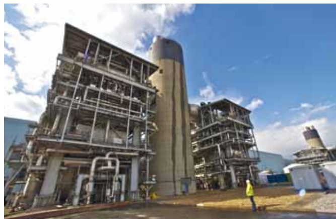
L'impianto di produzione di energia di Barking Power Station a Londra
