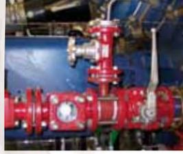
Valvole rivestite PTFE/PFA per prelievo campioni vuoto - azoto a magazzino
