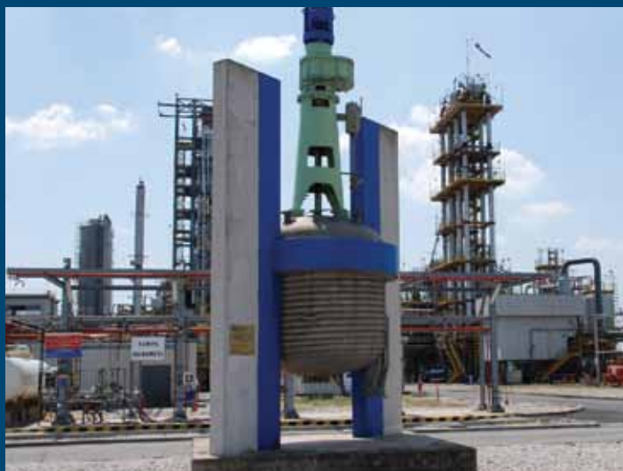
Monumento al Primo Impianto di Produzione - 1957, Centro Ricerche Giulio Natta di Ferrara
