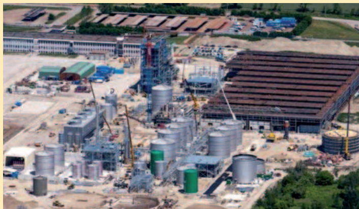
Impianto di Crescentino (VC)
