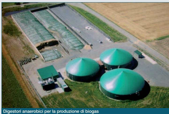
Digestori anaerobici per la produzione di biogas
