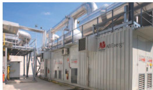
La soluzione modulare Ecomax® NGS per la cogenerazione a gas metano.
