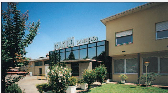
La sede centrale a Fabbrico (Reggio Emilia)
