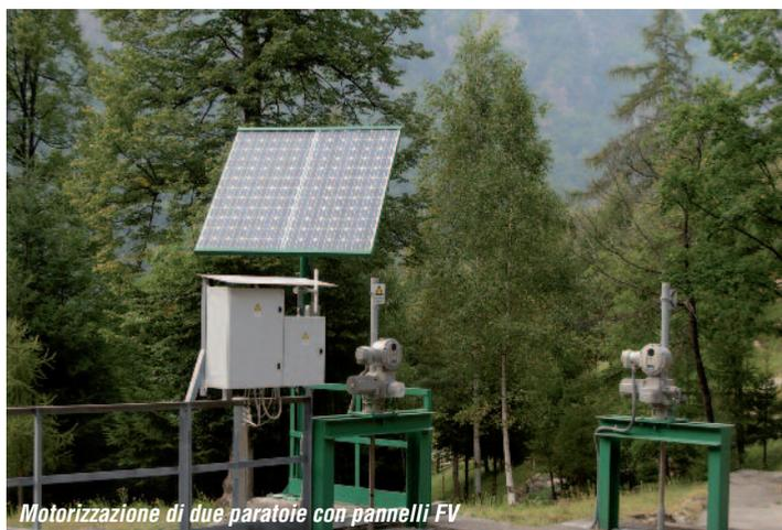
Motorizzazione di due paratoie con pannelli FV
