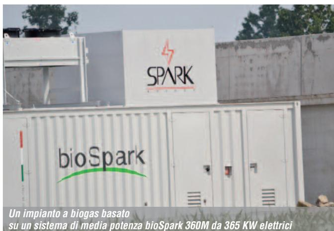
Un impianto a biogas basato su un sistema di media potenza bioSpark 360M da 365 KW elettrici
