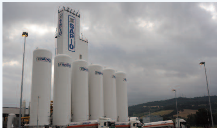
Impianto di frazionamento aria a Orte
