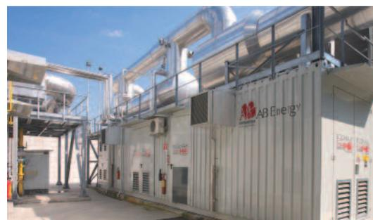
La soluzione modulare Ecomax® NGS per la cogenerazione a gas metano.
