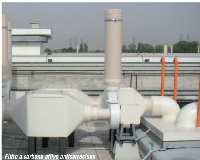
FilterBox a carbone attivo anticorrosione
