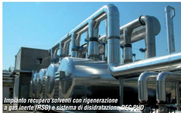
Impianto recupero solventi con rigenerazione a gas inerte (RSG) e sistema di disidratazione DEC PHD
