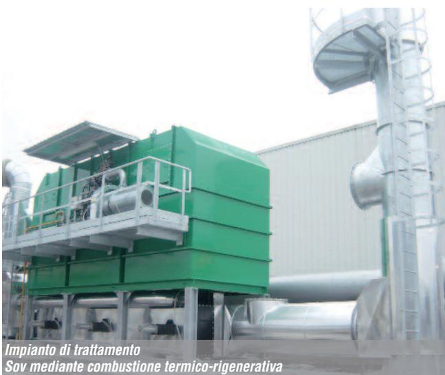
Impianto di trattamento Sov mediante combustione termico-rigenerativa
