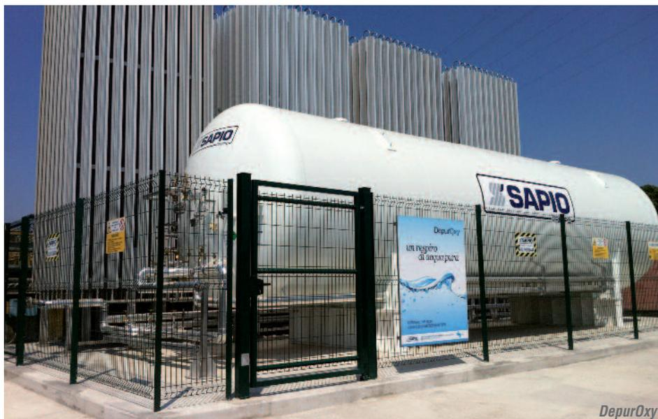
**Sapio** ha messo a punto recentemente alcune soluzioni innovative dedicate specificamente al settore ambientale. Nel settore del trattamento dell'acqua in particolare, un'applicazione che ha raggiunto risultati importanti riguarda la tecnologia DepurOxy, che punta sull'utilizzo dell'ossigeno puro. Il progetto è nato per risolvere i problemi di un caso specifico, riguardante il depuratore San Rocco del Comune di Monza, la città che ospita la sede centrale e storica del Gruppo Sapio.
