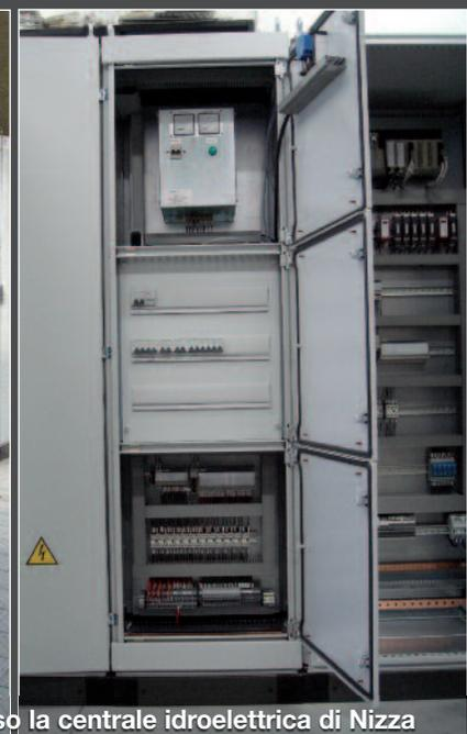
Armadi TS 8 in configurazione Ri4Power presso la centrale idroelettrica di Nizza
