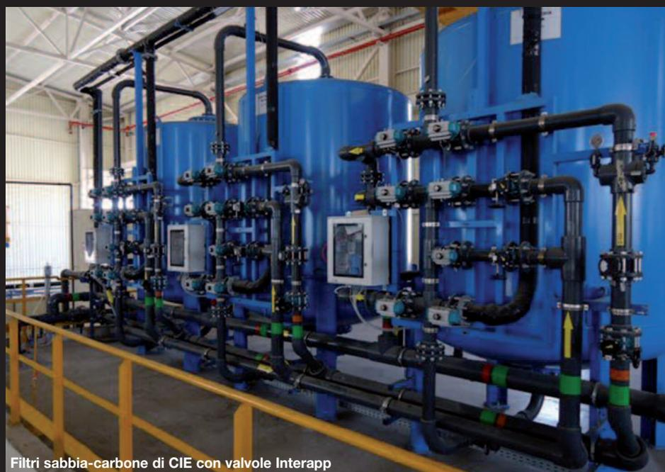
Filtri sabbia-carbone di CIE con valvole Interapp
