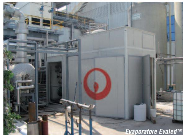
na si sta ora studiando l'applicazione di un trattamento tramite evaporazione. In questo caso, l'unità proposta è un Ehaled™ TC 60000 AA (sistema a ricompressione meccanica del vapore) poiché non si dispone di acqua calda/fredda in eccesso.
