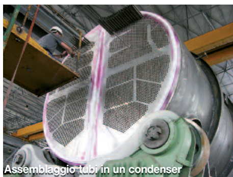
Fase di assemblaggio
