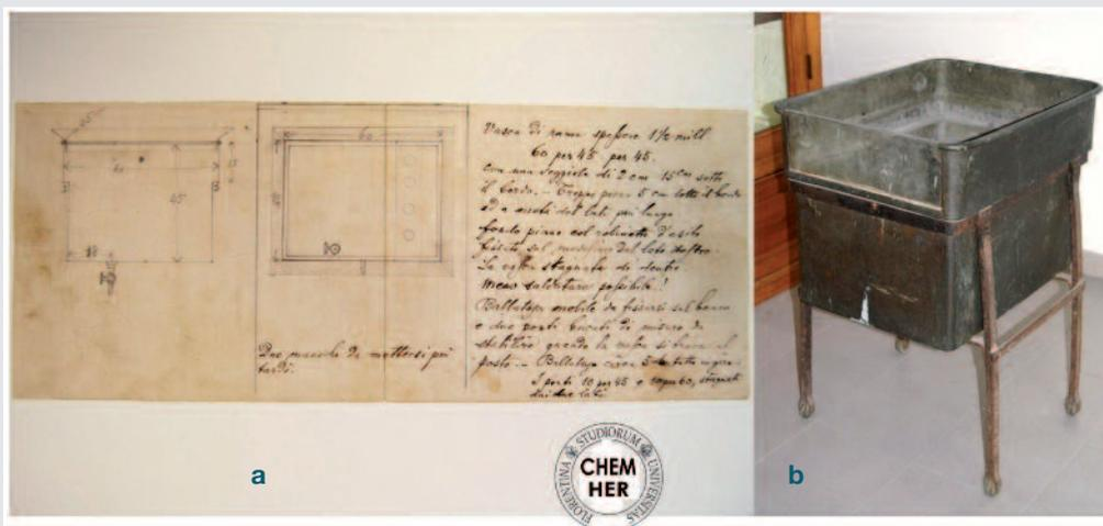
Fig. 7 - Progetto di Schiff per la costruzione di una vasca termostatica in rame da inserire nel banco chimico e a destra la stessa vasca oggi
