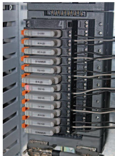
**Marshalling elettronico con CHARMS e funzionalità I/O on Demand del sistema di automazione DeltaV versione 11**
