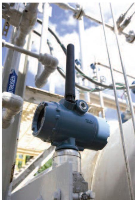
**Strumento di misura wireless Rosemount**
