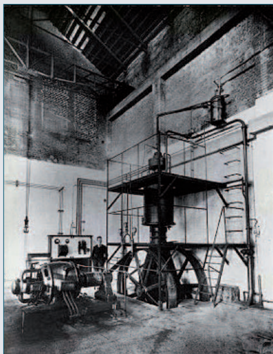
Fig. 5 - Primo impianto di sintesi dell'ammoniaca realizzato a Novara da Fauser
