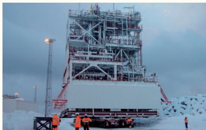
*Trasporto di un impianto di liquefazione del gas in Norvegia*
