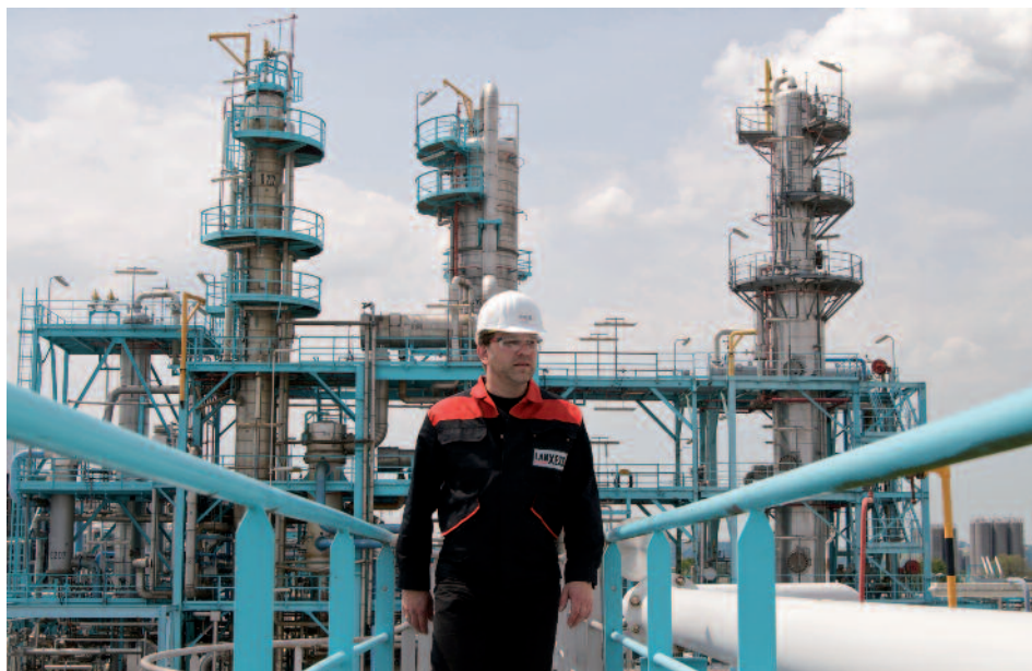
Torri di distillazione a Port Jerome
