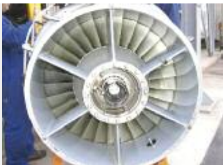
Ingresso compressore turbogas
