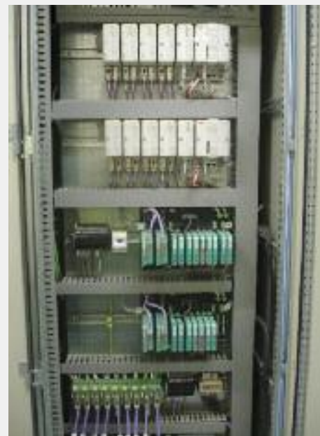
Armadio contenente Power HUB SK3 con gateway ridondante (verde), modulo ADM di Pepperl+Fuchs (rosso) e moduli del sistema 800 XA di ABB (bianchi)
