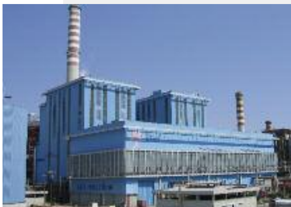
La centrale a idrogeno di Fusina (Venezia)
