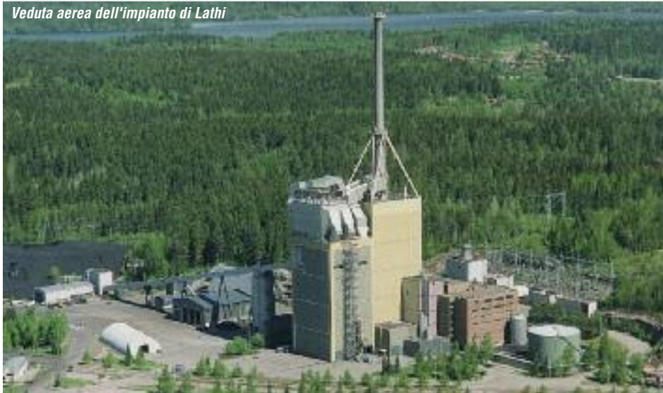
Veduta aerea dell'impianto di Lathi
