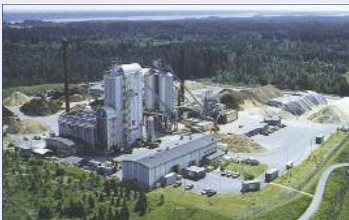
Impianto di gassificazione di biomassa
