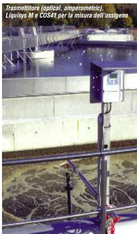
*Trasmettitore (optical, amperometric), Liquisys M e COS41 per la misura dell'ossigeno*
