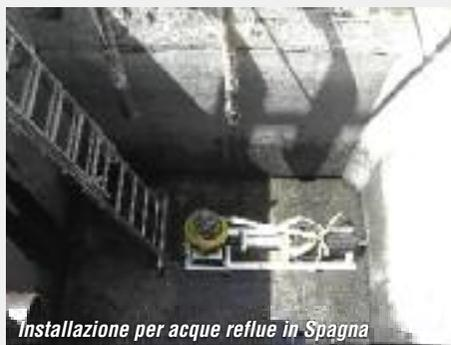
Queste unità sono state dotate di giranti in bronzo, tenute meccaniche e sensori di temperatura dei cuscinetti, e sono state scelte per la capacità di ridurre i tempi morti, particolarmente onerosi in miniera. La società ha inoltre partecipato a due progetti a Toledo (Spagna), con l'installazione in serie di elettro-
