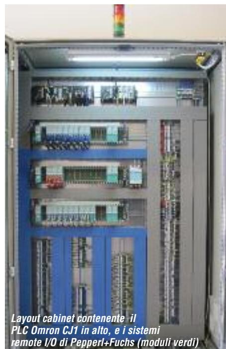
Layout cabinet contenente il PLC Omron CJ1 in alto, e i sistemi remote I/O di Pepperl+Fuchs (moduli verdi)
