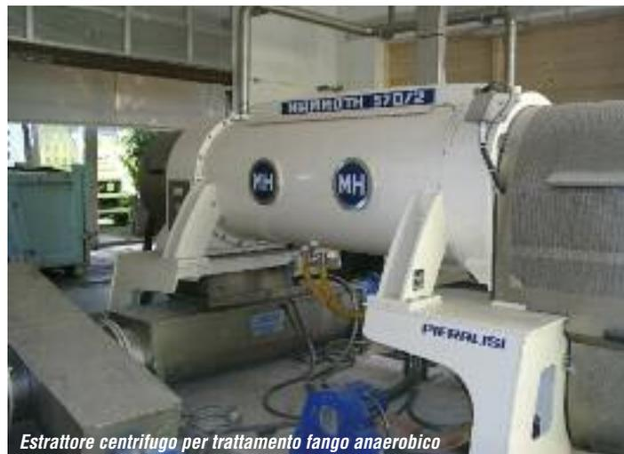
Estrattore centrifugo per trattamento fango anaerobico
