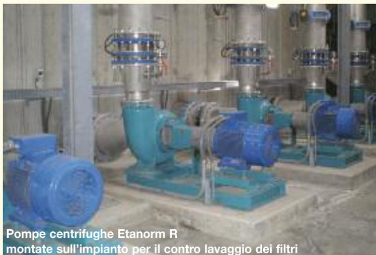
Pompe centrifughe Etanorm R montate sull'impianto per il contro lavaggio dei filtri
