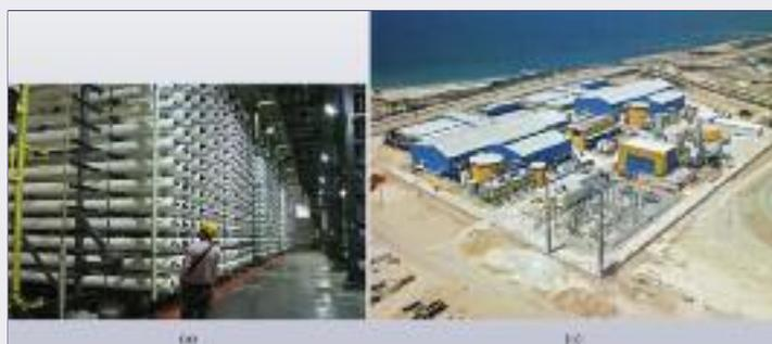
Fig. 2 - Moduli di osmosi inversa (a) utilizzati nell'impianto di dissalazione (b) di Ashkelon - Israele (fonte: www.water-technology.net/projects/israel/)
