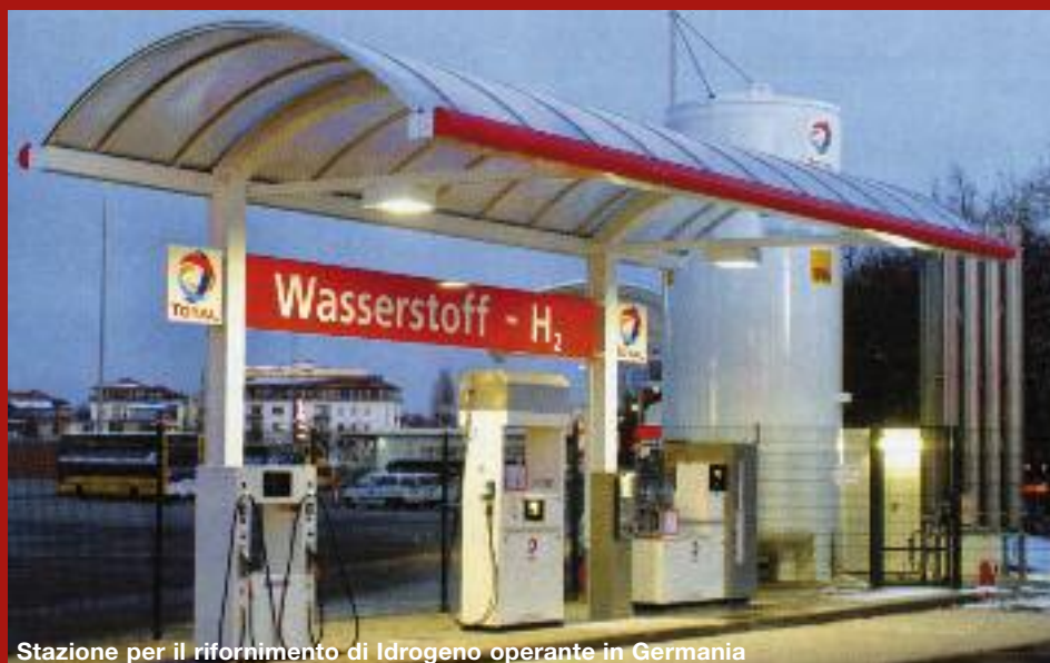
Stazione per il rifornimento di Idrogeno operante in Germania
