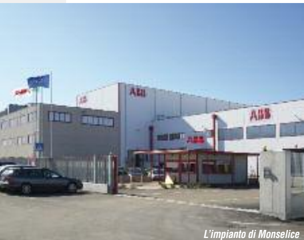
L'impianto di Monselice
