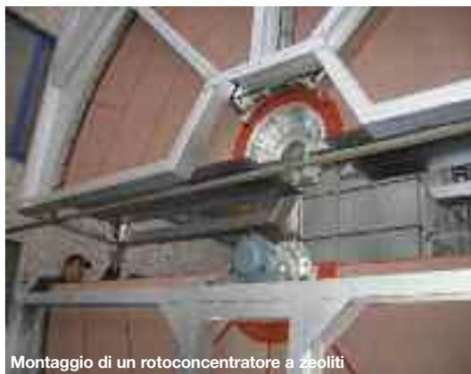
Montaggio di un rotoconcentratore a zeoliti
