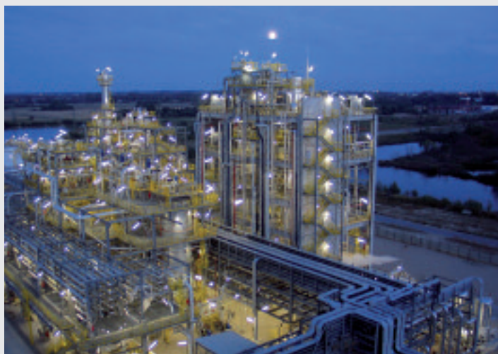
Impianto Lyondell-Basell in Olanda
