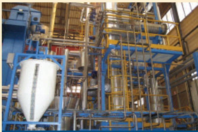
Impianto sperimentale di ristrutturazione molecolare catalitica
