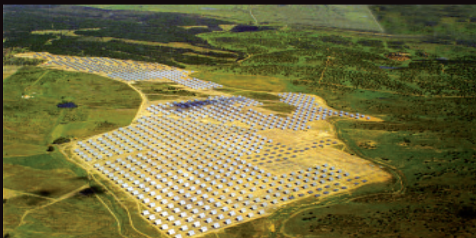
Impianto fotovoltaico di Alentejo Plain a Moura, Portogallo: è il più grande del mondo (45 MW)
