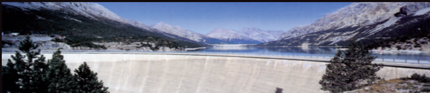
La diga di Cancano, in Alta Valtellina, realizzata negli anni 50 ad un'altitudine di circa 2000 metri, è un bacino artificiale molto importante con una capacità che arriva fino a 123 milioni di m 3 di acqua
