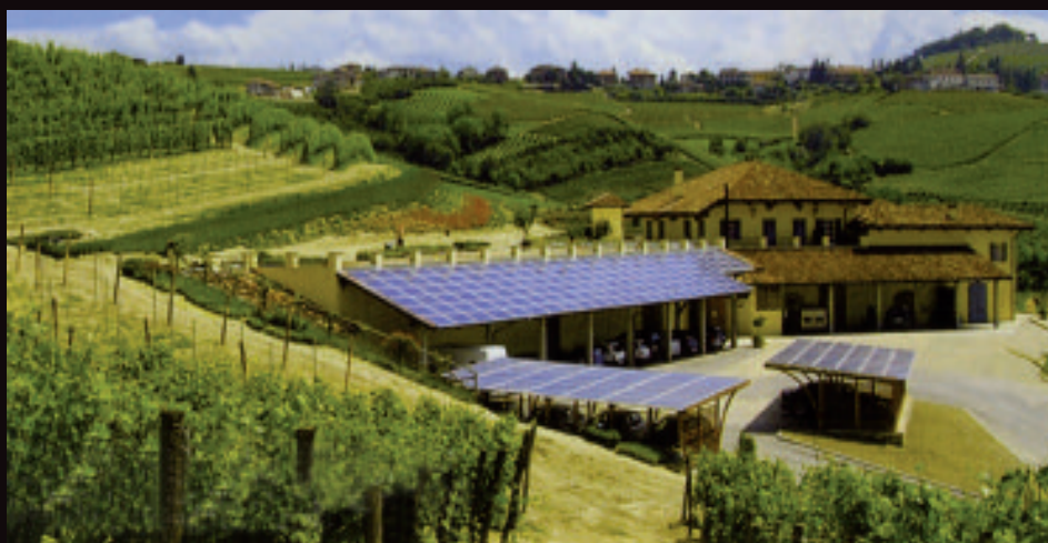
Impianto fotovoltaico a totale integrazione architettonica con potenza di 50 kW
