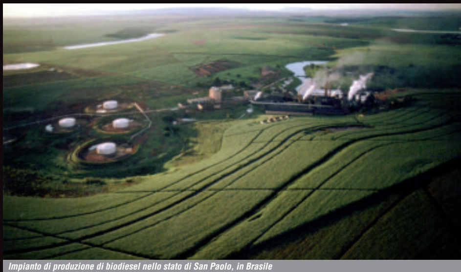
Impianto di produzione di biodiesel nello stato di San Paolo, in Brasile
