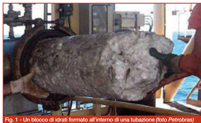
Fig. 1 - Un blocco di idrati formato all'interno di una tubazione (foto Petrobras)
