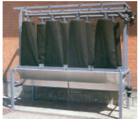
Elementi di accumulo e drenaggio a manica filtrante per melme e fanghi
