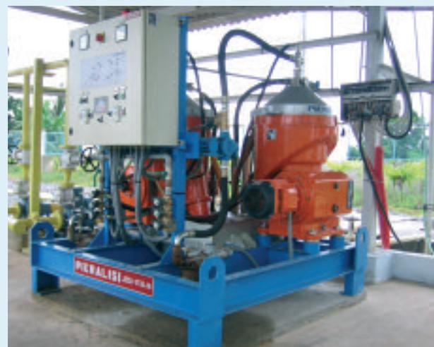
Separatore a dischi per gasolio installato presso centrale elettrica in Ecuador
