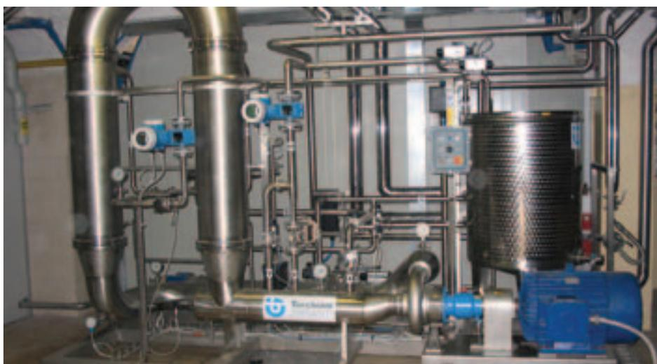
*Impianto di ultrafiltrazione ceramico per la separazione brodo/micelio (downstream processing)*
