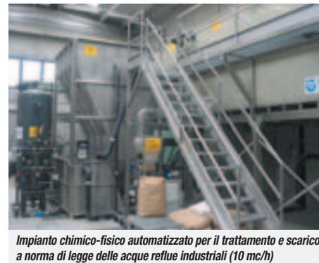
*Impianto chimico-fisico automatizzato per il trattamento e scarico a norma di legge delle acque reflue industriali (10 mc/h)*
