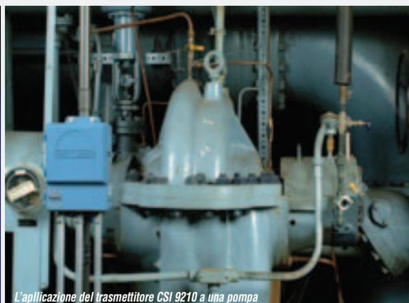
L'applicazione del trasmettitore CSI 9210 a una pompa
