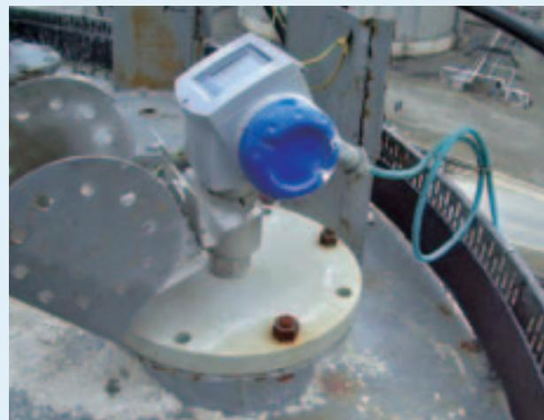
Misuratore di livello radar Optiflex 1300
