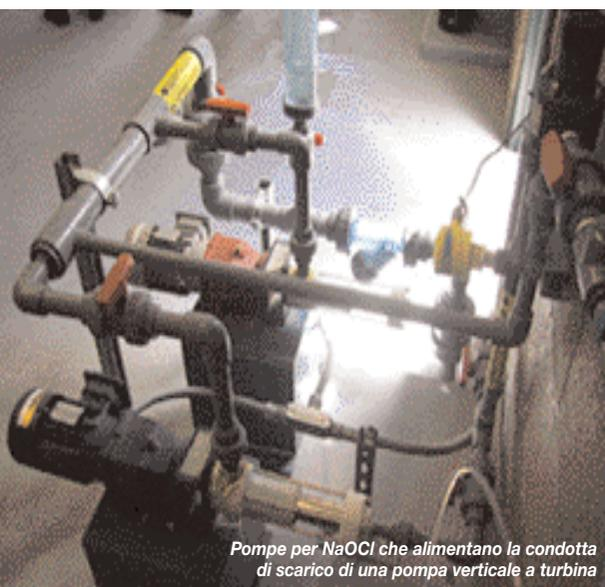
Pompe per NaOCl che alimentano la condotta di scarico di una pompa verticale a turbina
