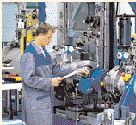
Di quanto installato in un sistema di automazione, i componenti in campo sono quelli maggiormente critici per gli aspetti manutentivi
