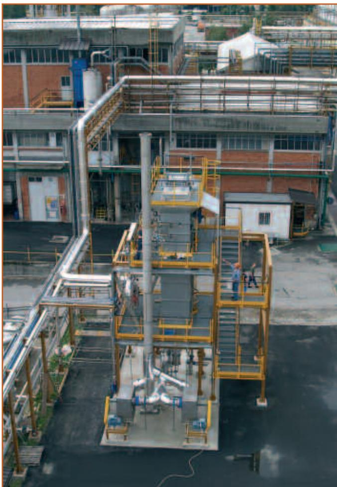
Fig. 14 - Impianto di termodistruzione sfiati gassosi
