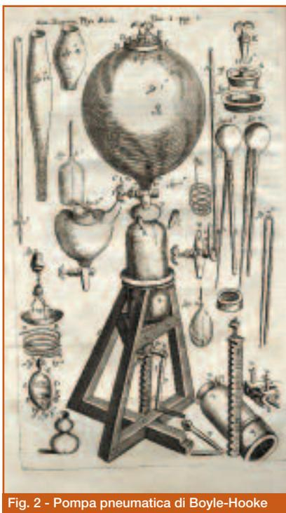
Fig. 2 - Pompa pneumatica di Boyle-Hooke
