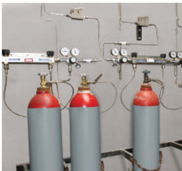
Rampa a idrogeno con telecontrollo
