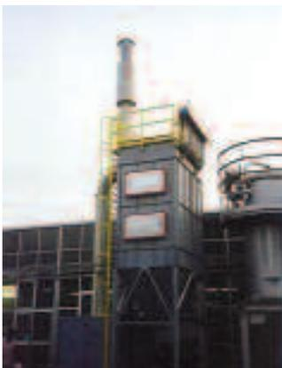
Aspirazione e filtrazione di polveri di Al, Sn e Zn da flammizzazione su condensatori
