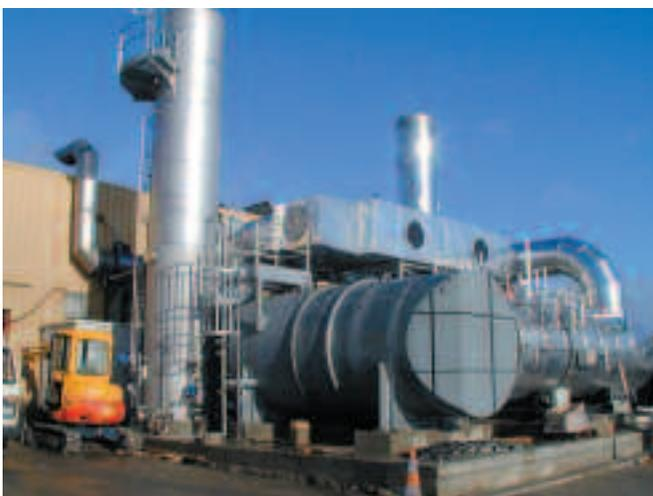
Ossidatore termico recuperativo per gas e liquidi con abbattimento a umido
