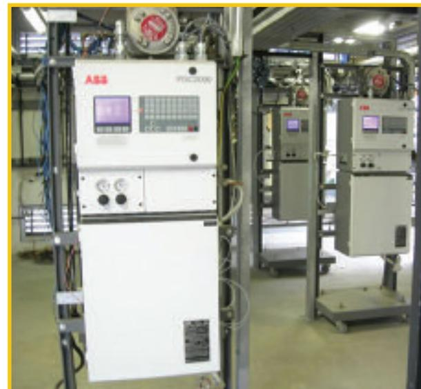
Nell'impianto Catalloy sono installati 5 gascromatografi ABB
