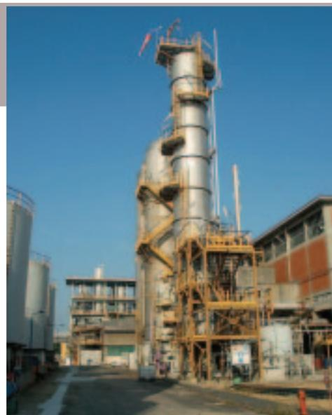
Fig. 3 - Impianto Radici Chimica - Novara. In primo piano: torre di assorbimento con acqua ossigenata
